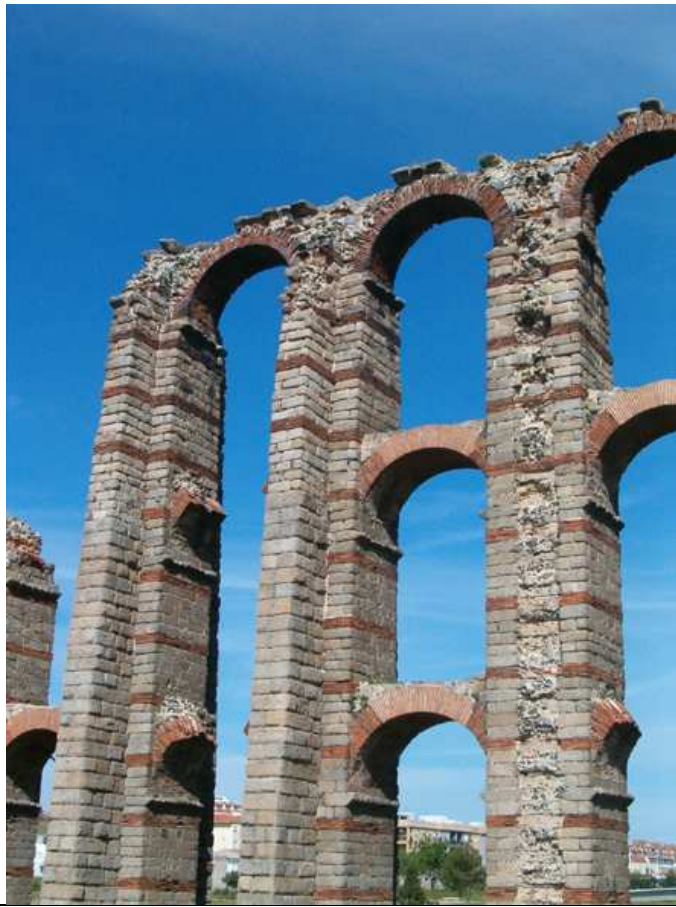
Detalle del acueducto romano de Mérida (Badajoz) Pueden apreciarse los tres órdenes de arquerías
