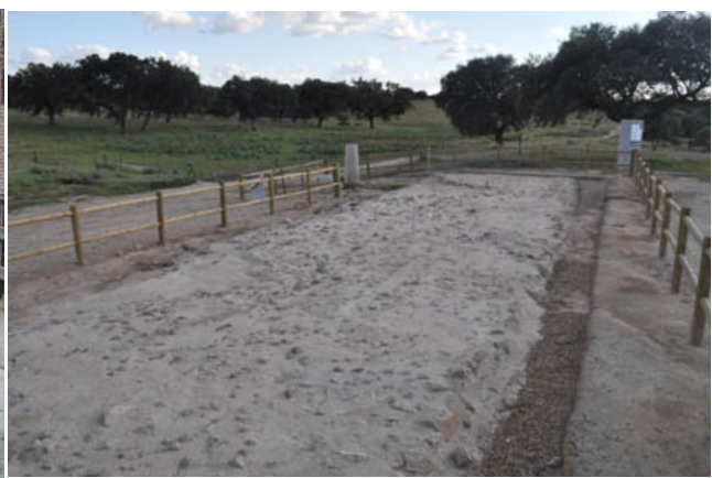
Vía de la Plata. El desgaste del tiempo y la excavación han hecho desaparecer la capa de rodadura superficial, dejando al descubierto el rudus (capa de guijarros medianos)
