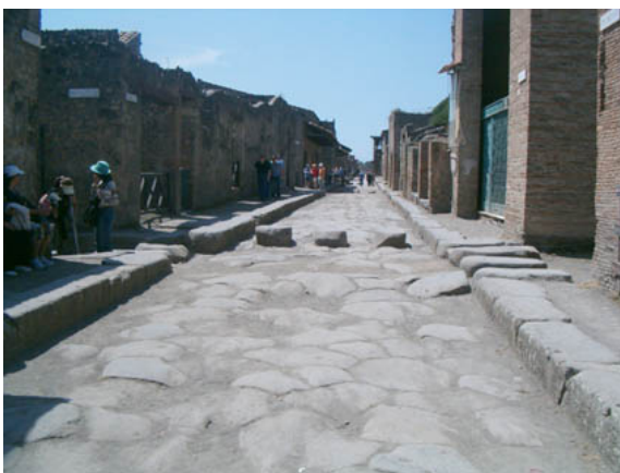
Calle de Pompeya. La parte superior de la calle está rematada con lajas de piedra (silex), que constituyen la summa crusta (literalmente "costra superior")
