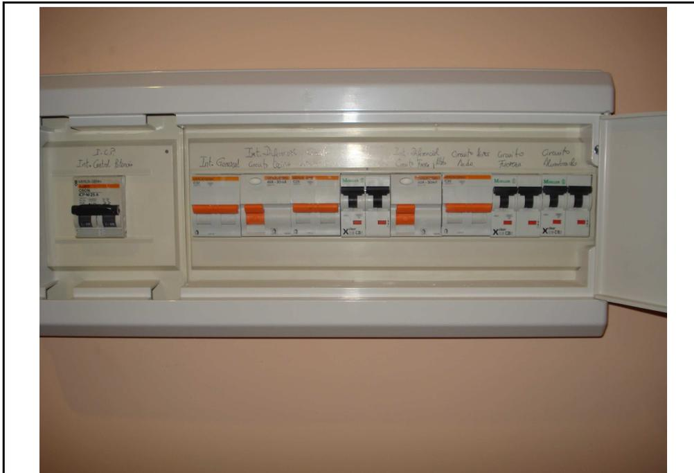
Imagen 5: Cuadro eléctrico de protección en una vivienda. Compuesto por: ICP, IGA, PIAS e ID.
