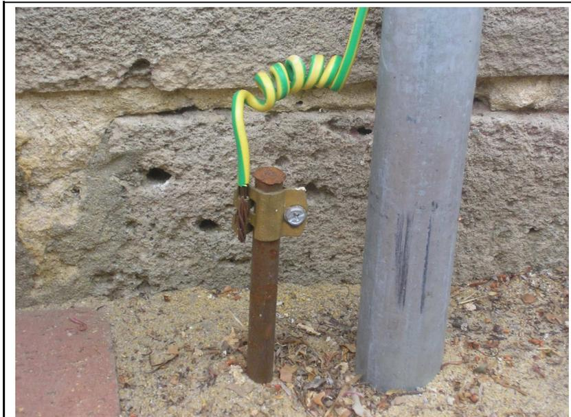
Imagen 24: Electrodo o pica de tierra (Izquierda) de una vivienda. El cable verde y amarillo es el conductor de tierra.
